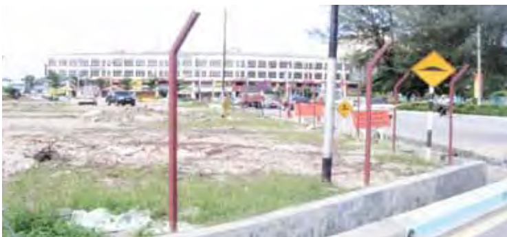
Kerja Awalan Pembinaan Kompleks Wakaf, Seksyen 9, Kajang, Selangor.
