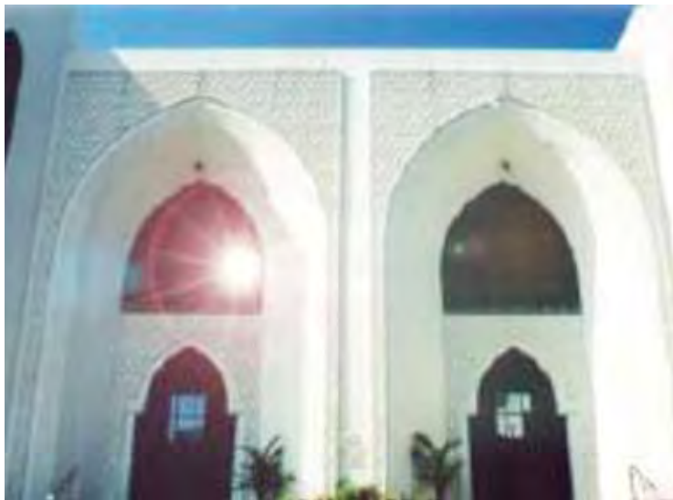
Aras 3, Blok Perpustakaan Islam Jakim, Jalan Perdana, Kuala Lumpur.
