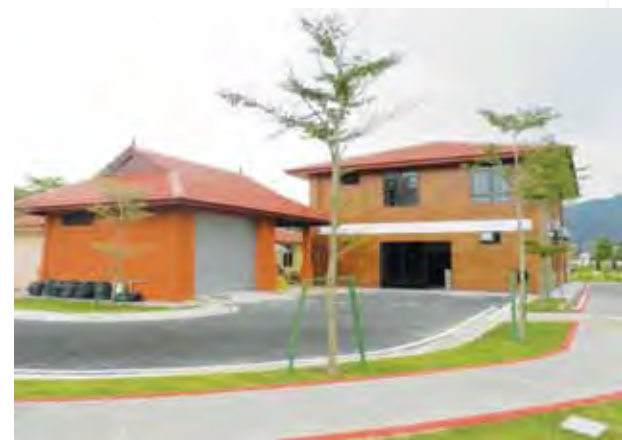
Bangunan pentadbiran Kawasan Perkuburan KL-Karak.
